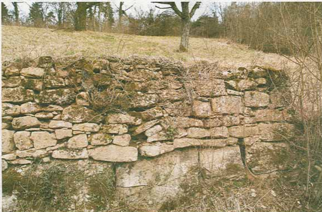
Bruchsteinmauer im Gebiet Krähhalde: Landschaftsgestalterisches und ökologisch wertvolles Objekt.
