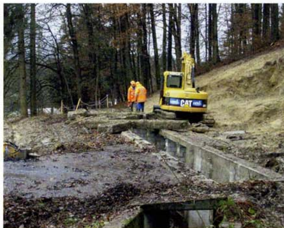
Rückbau des Scheibenstandes nach dem Abtransport des bleibelasteten Materials. Bild: Esther Krummenacher
