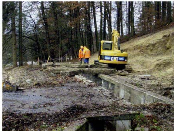
Rückbau des Scheibenstandes nach dem Abtransport des bleiblasteten Materials. Bild: Esther Krummenacher
