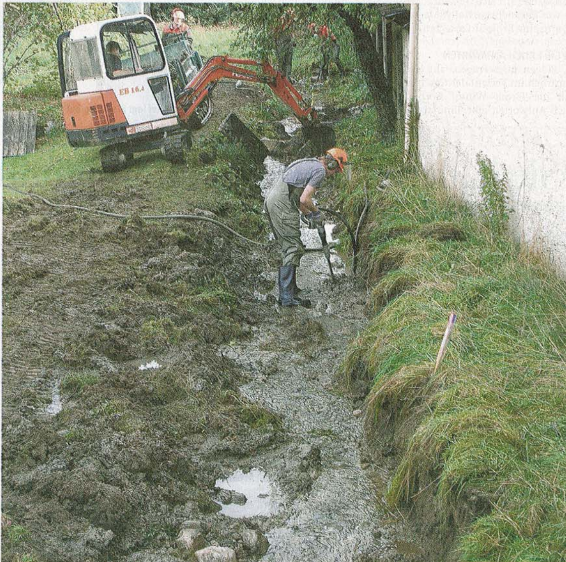
Zivilschutzangehörige verrichten Arbeiten im Dienst der Allgemeinheit wie hier bei der Renaturierung eines Seoner Baches. TF
